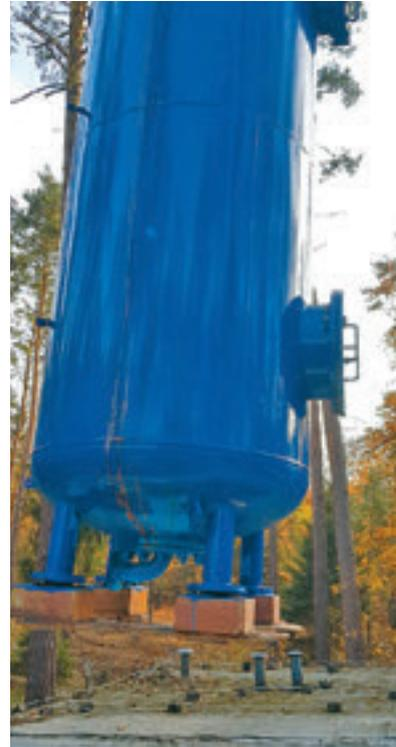
Die neuen Filter werden über den „Luftweg“ in das Wasserwerk gehoben.
