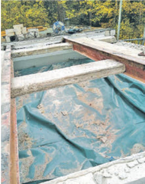
Das Dach des Wasserwerks Klein Briesen musste geöffnet werden, um die neuen Filter installieren zu können.
