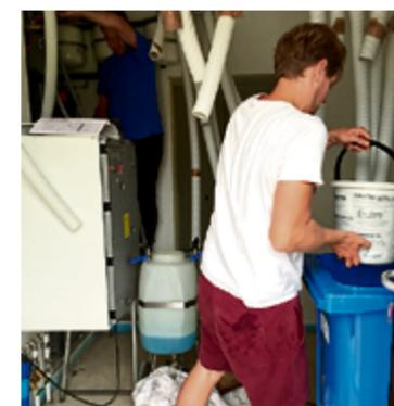
Befüllen der Wärmepumpe: Die Sole (ein Gemisch aus Wasser und speziellem Alkohol) wird per Druckpumpe in die insg. 440m Soleleitung gepumpt.
