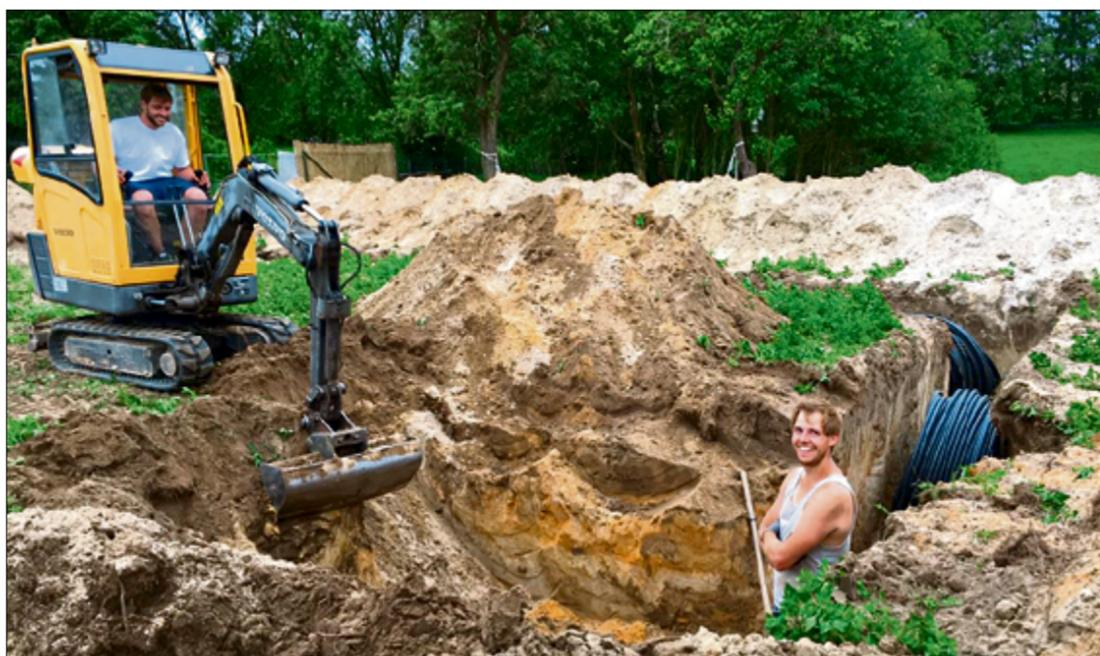
Bagger fahren macht nicht nur Spaß, sondern ist auch wichtig, denn ohne die maschinelle Hilfe wäre das Ausheben des 220m langen, 1,50m tiefen und 0,80m breiten Grabens kaum möglich.
