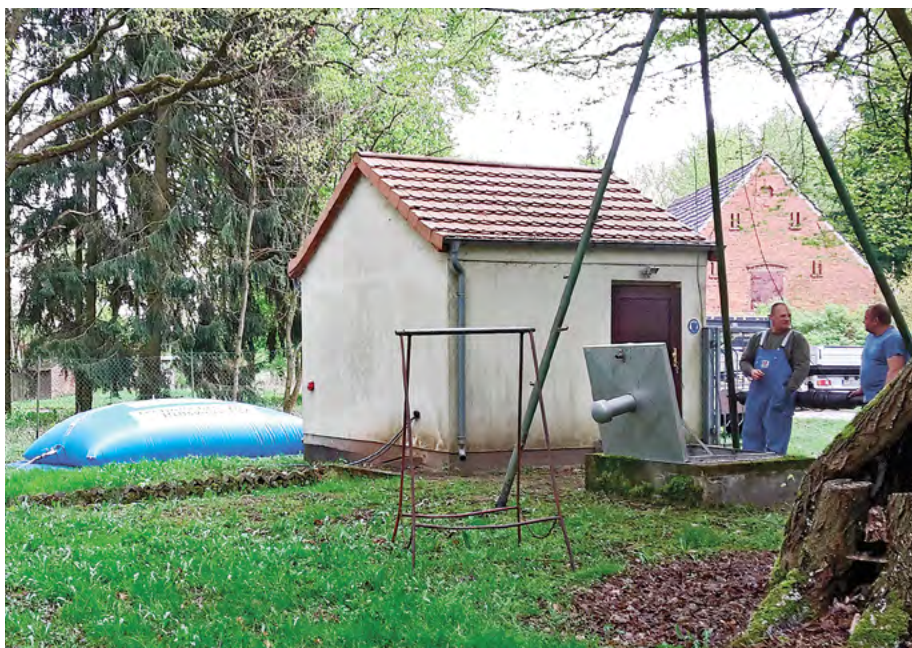
Seit über 60 Jahren fördert ein Brunnen für den Weitzgrund Grundwasser, das in einem Mini-Wasserwerk aufbereitet wird. Im April versorgte eine Notwasserblase (hinten) vorübergehend die Anwohner.
